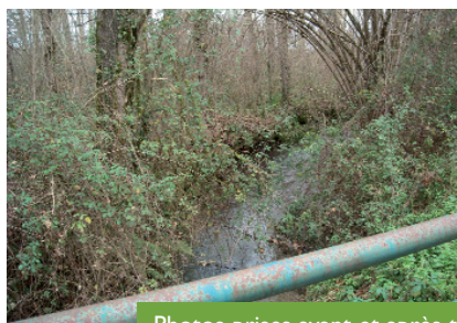
Photos prises avant et après travaux, vues vers l'aval du pont Grangé (Lech, commune d'Arthez-de-Béarn)
